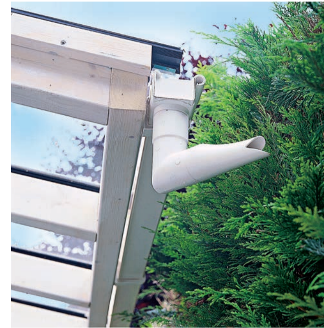
An die untere Pfette schrauben Sie eine Kastenrinne von 70 mm Breite. Diese Größe genügt für die kleine Vordachfläche. An den Seiten sollte die Rinne etwa 3-5 cm überragen.
