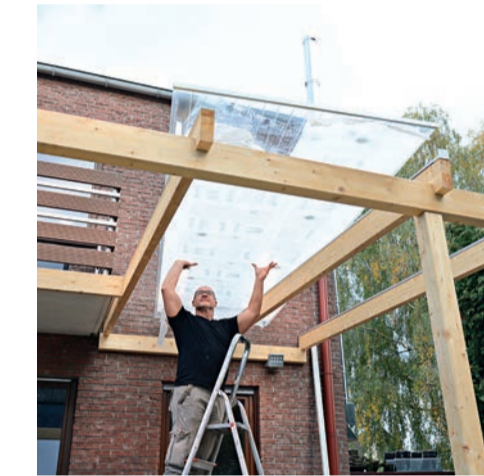
Ein Vorteil der Kunststoff-Hohlkammerplatten ist das geringe Gewicht. Damit kommt man auch allein gut klar beim Eindecken.
